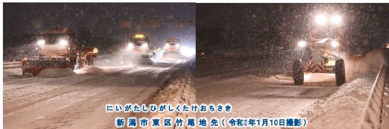
国道7号竹尾IC付近の除雪
