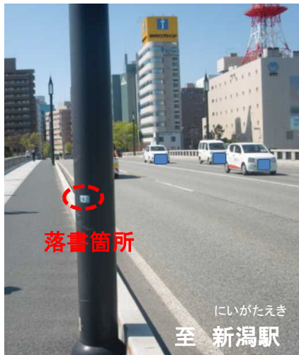
【写真】落書箇所（全景）
