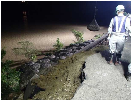
袋詰め玉石設置
