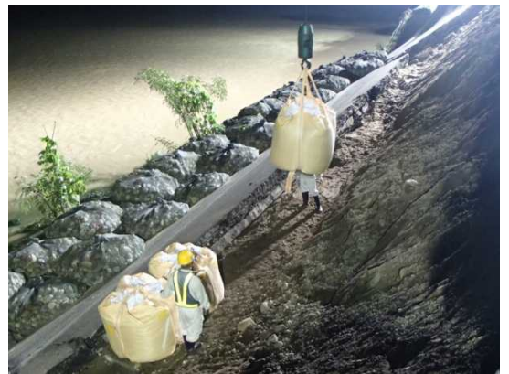
大型土のう設置
