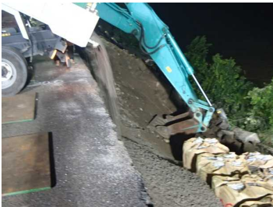
裏込材（碎石）投入
