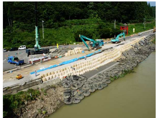
応急復旧完了
