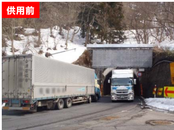
揚川トンネル
