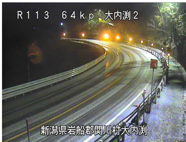
20日午後22時頃の 国道113号大内湊の状況
