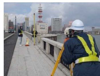
歩道上の測量作業
