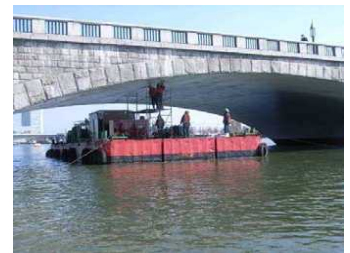
台船による橋梁定期点検
