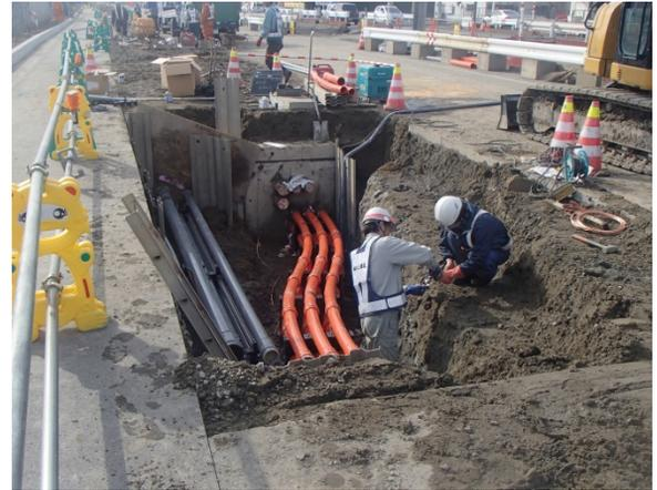
無電柱化の推進：拡幅工事に伴い、電線類を地中化し無電柱化を行っています。
