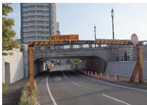
第8径間(新潟駅)側
