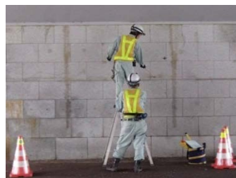
萬代橋の交差している市道上の点検
