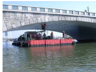
台船による橋梁定期点検
