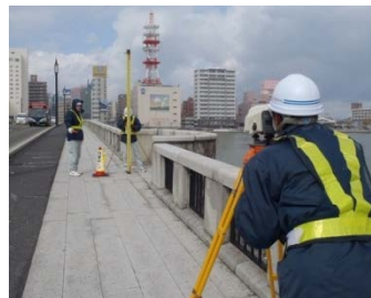
(観測鉞) 観測鉞の間隔を測量にて確認
