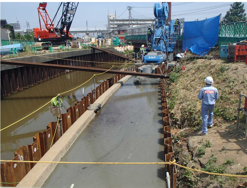
写真-2 仮締切内の状況
