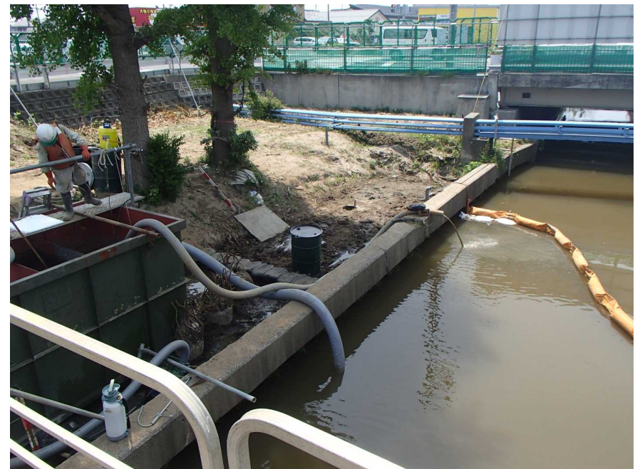
写真-4 栗ノ木川への残水放流状況
