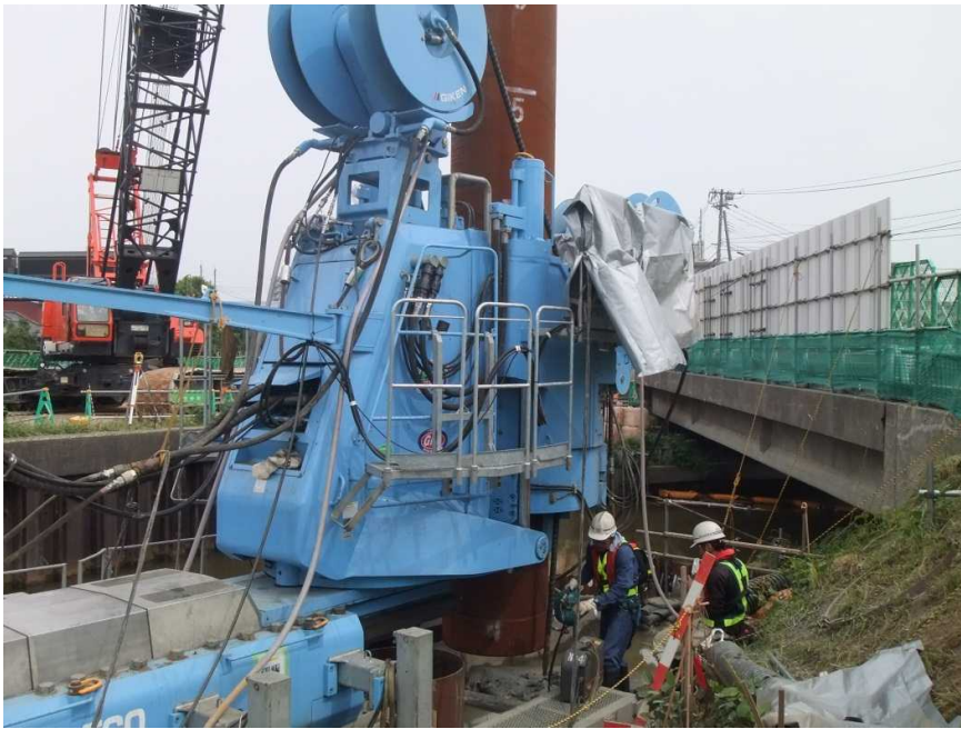
写真-1 鋼管矢板打込み状況
