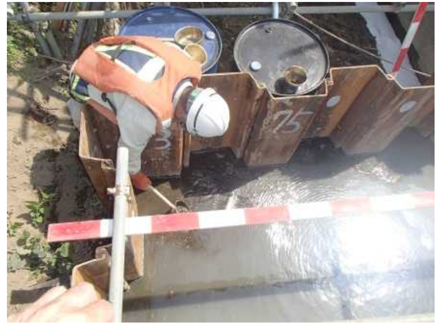
写真-3 油分の回収状況
