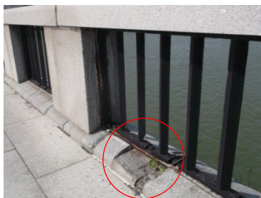
②高欄補修(高欄の損傷)
