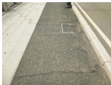
④歩道舗装補修(ひび割れ、段差)
