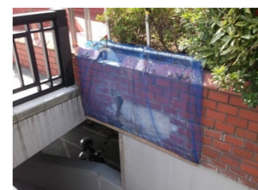
⑤階段部補修 階段部レンガの浮き(応急対策後)
