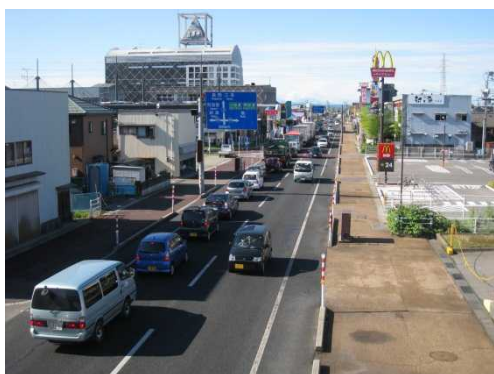
白根歩道橋付近の状況
