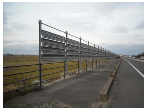
防雪柵張り出し後
