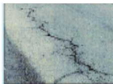
舗装のひび割れ
