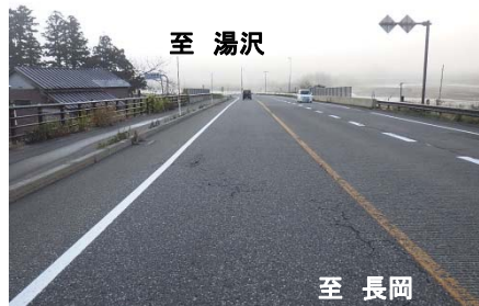
高い速度でカーブに進入し車線逸脱
