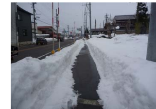
歩道除雪実施により、冬期も安全な歩行区間を確保
