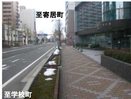
植樹帯等による歩道狭小箇所
