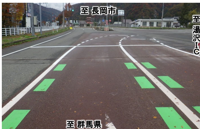
＜国道17号湯沢IC入口交差点 カラードットライン(緑)設置状況＞
