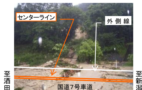
土砂災害(村上市大沢地区)
