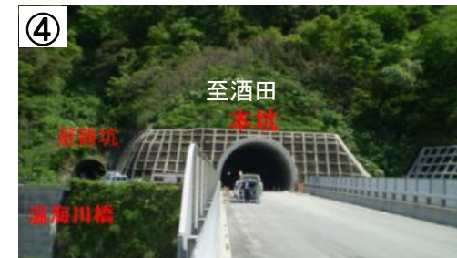
日沿道温海トンネル(南側坑口)
