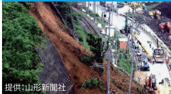
法面崩壊 鶴岡市小岩川
