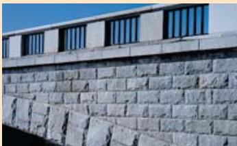
現在の萬代橋は三代目のもの。鉄筋コンクリート造6連アーチ橋で、橋長306.9m、幅員22.0m。表面は茨城県真壁産の御影石によって美しく仕上げられています。
