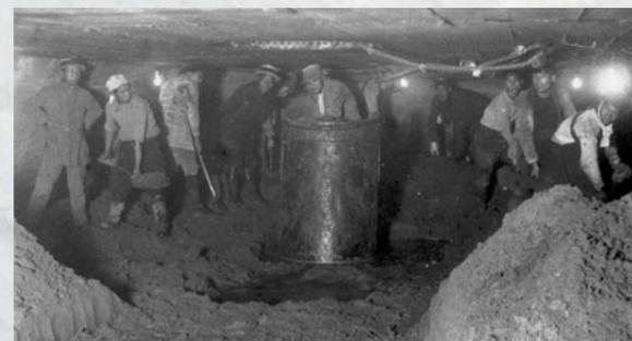
▲潜函作業室内の掘削の様子
