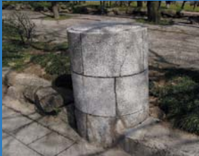
C 旧橋詰階段親柱
