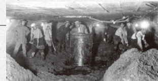
川底での空気潜函工事の様子
