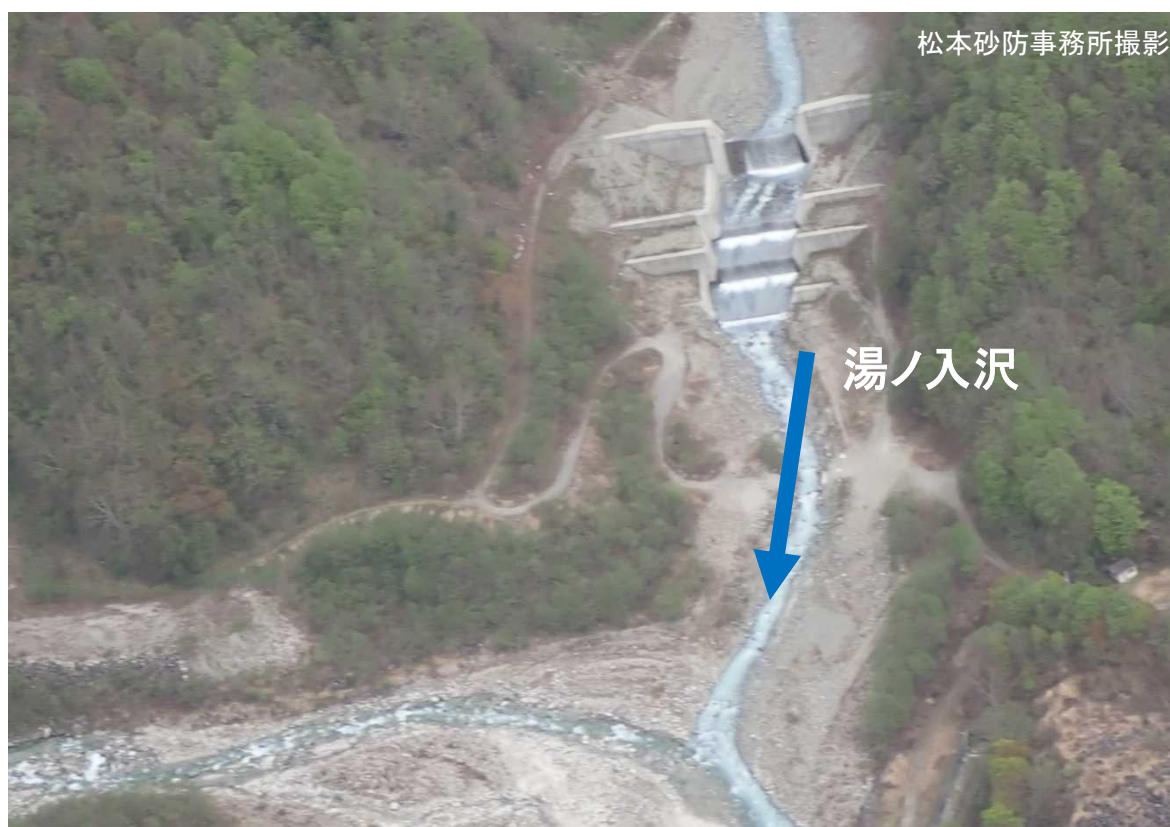
写真-2 湯ノ入沢第1号砂防堰堤
