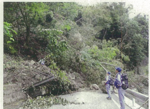
▲ 岩手県岩泉町被災状況調査 （東北地整TEC-FORCE）
