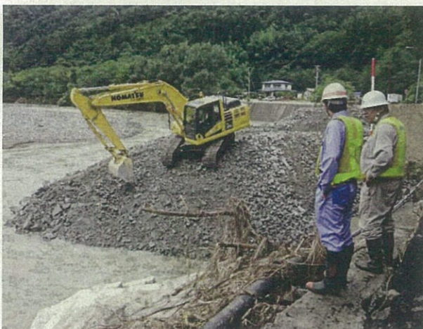
▲ 岩手県岩泉町（R455）復旧作業状況 （東北地整TEC-FORCE）
