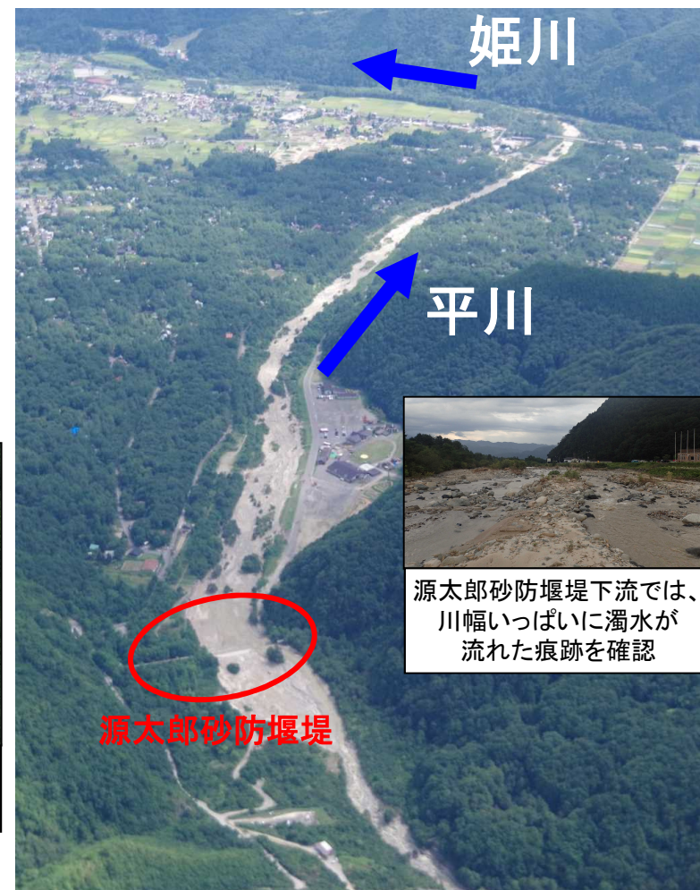
写真-2 源太郎砂防堰堤付近
