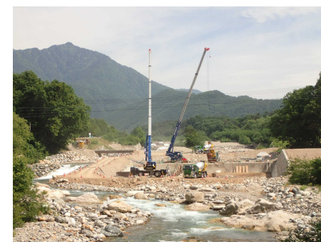
今年完成予定の日向山第1号上流床固工
