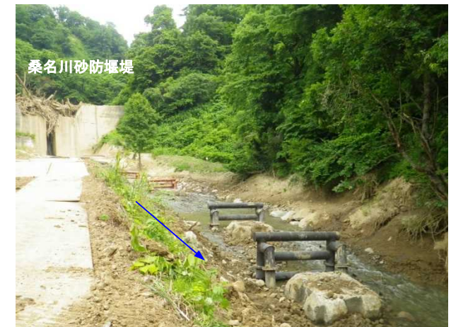
設置完了(6月17日(土))
