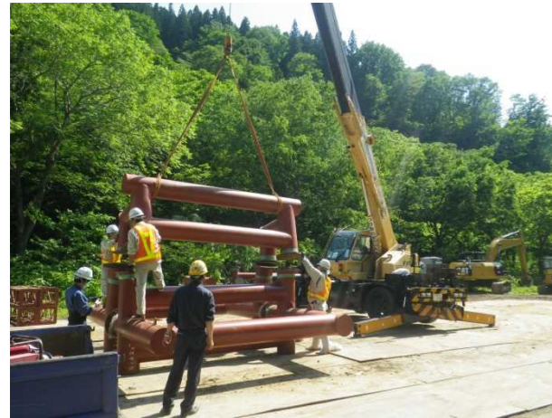
組み立て状況(6月15日(木))
