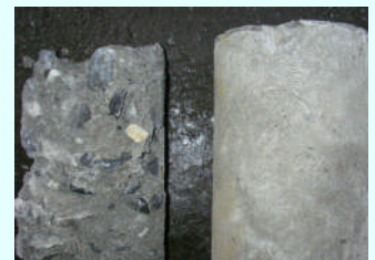
【写真2 打設後11日目】
