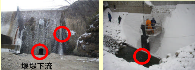
堰堤上流: 鋼板設置状況
