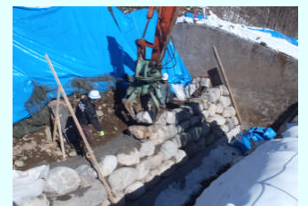
アタッチメントによる巨石積み
