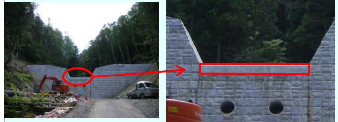
堰堤上流: 鋼板設置状況
