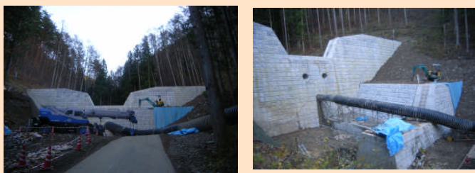
写真 施工状況 11月25日撮影
