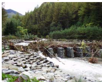
栃洞沢床固工群流木捕捉 (台風23号 H16.10)
