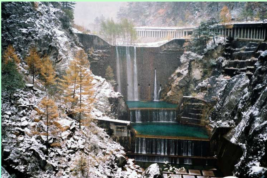
「登録有形文化財」 上高地 釜ヶ淵砂防堰堤（昭和 19 年竣工）
