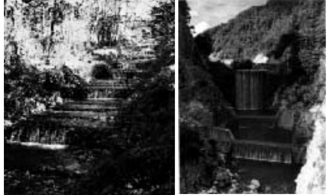
牛伏川フランス式階段工(明治30年砂防法施行後、国庫補助により長野県施工) わが国はじめてのアーチ型砂防ダム(釜ヶ淵上流砂防ダム 内務省直轄施工)
