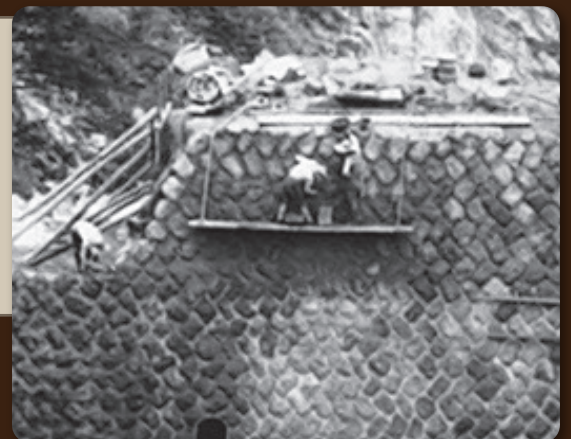
石積の作業風景
