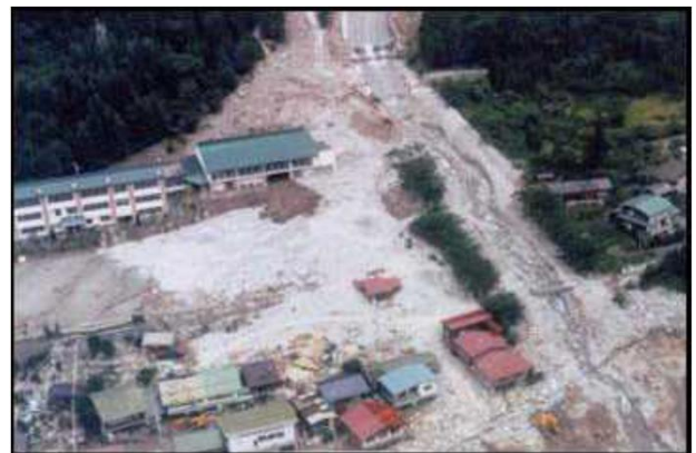
洞谷からの土石流が栃尾温泉街を直撃 (昭和54年洞谷災害)
