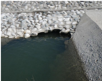
損傷した護岸の修繕
