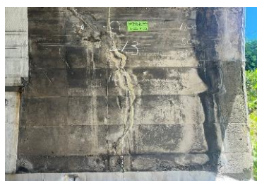
（覆工の損傷）
