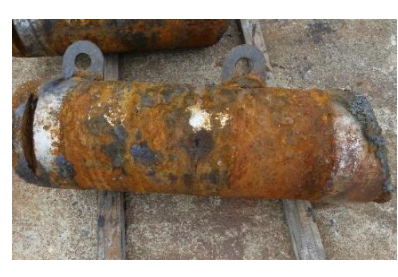
腐食したゲート設備の修繕
