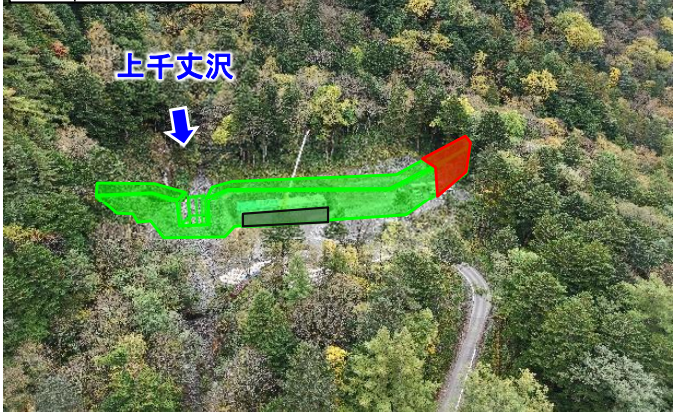
上千丈沢砂防堰堤
