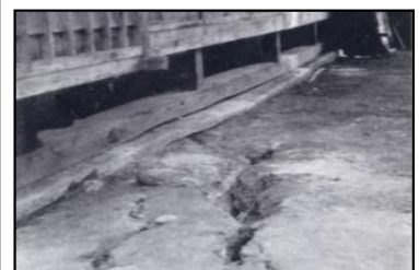
◆S33年頃 ひきまき 引牧の住居軒下の開口亀裂
