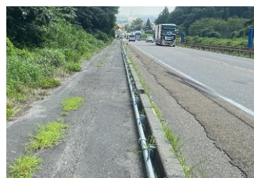
（対策イメージ：消雪設備設置）
