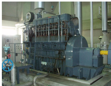
排水機場原動機の更新
