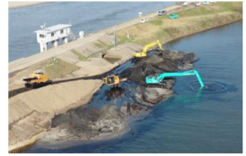
堆積土砂の撤去
