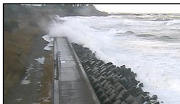
片山津工区No676付近 (令和5年1月16日)
