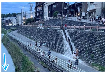
①階段整備状況（金沢市）
