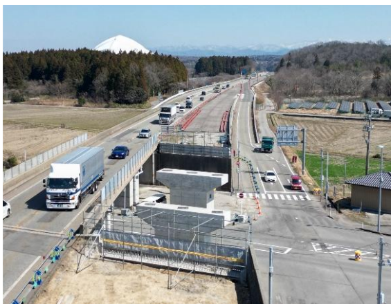
▲ 橋梁下部工事の施工状況
