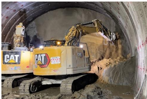
▲森本トンネル工事の施工状況
