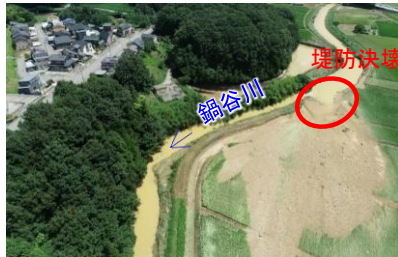
②堤防決壊 (小松市上八里町)
