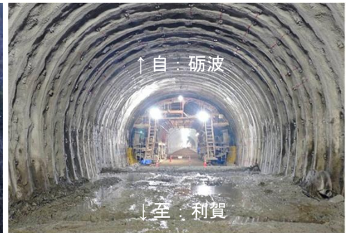
利賀トンネル施工状況 南砺市利賀村（令和8年2月撮影）
