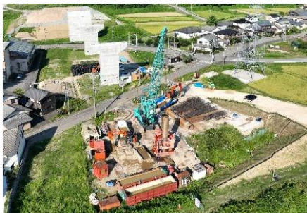
▲ 橋梁下部工事の施工状況
