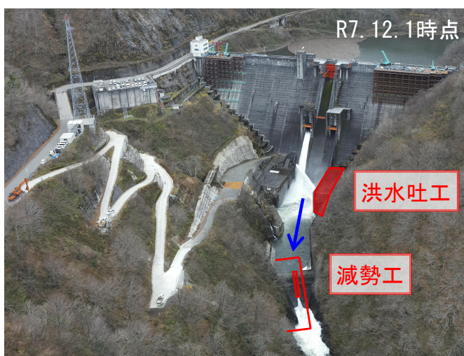
胎内川ダム洪水吐増設工事中(R7. 3. 21~)
