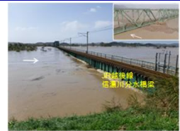
JR越後線信濃川分水橋梁付近の状況 （令和元年10月13日12時頃）
