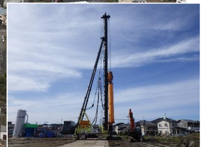
▲ 地盤改良の施工状況
