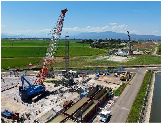
▲ 橋梁下部工事の施工状況
