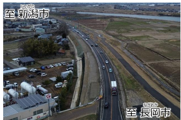
写真② R6年度施工状況
