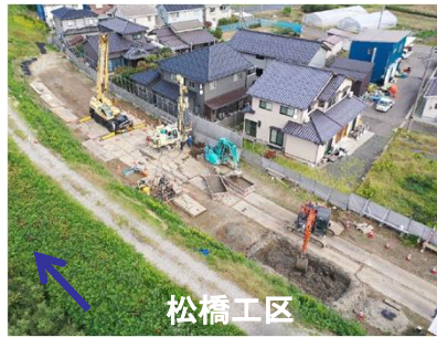
地盤改良実施状況
