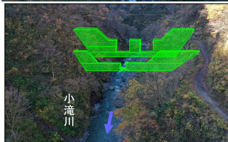
小滝川第1号下流砂防堰堤
