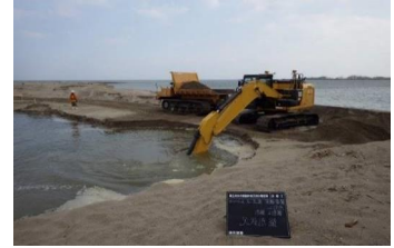
堆積土砂の撤去
