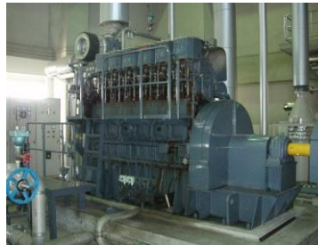
排水機場原動機の更新
