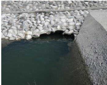
損傷した護岸の修繕
