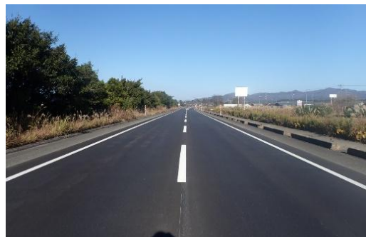
【対策イメージ】舗装（路盤）打ち換え
