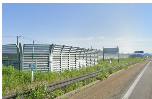
【対策イメージ】防雪柵設置工
