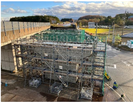
▲橋梁下部工事の施工状況
