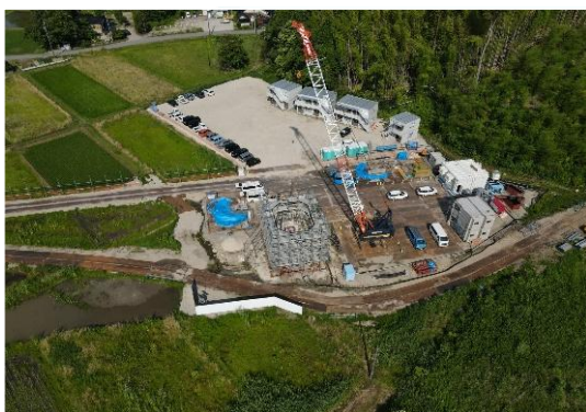
▲橋梁下部工事の施工状況 田鶴浜七尾道路
