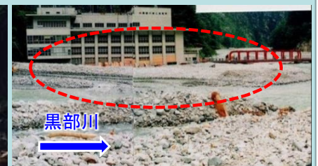
土砂流出により発電施設が埋没
