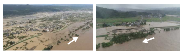
長野市穂保地先の堤防決壊、新潟県小千谷市内における浸水被害状況
