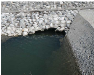
損傷した護岸の修繕
