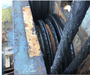
回転不良が生じている 滑車の更新
