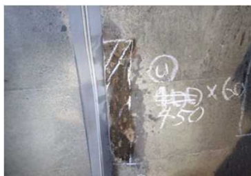
（覆工の損傷）
