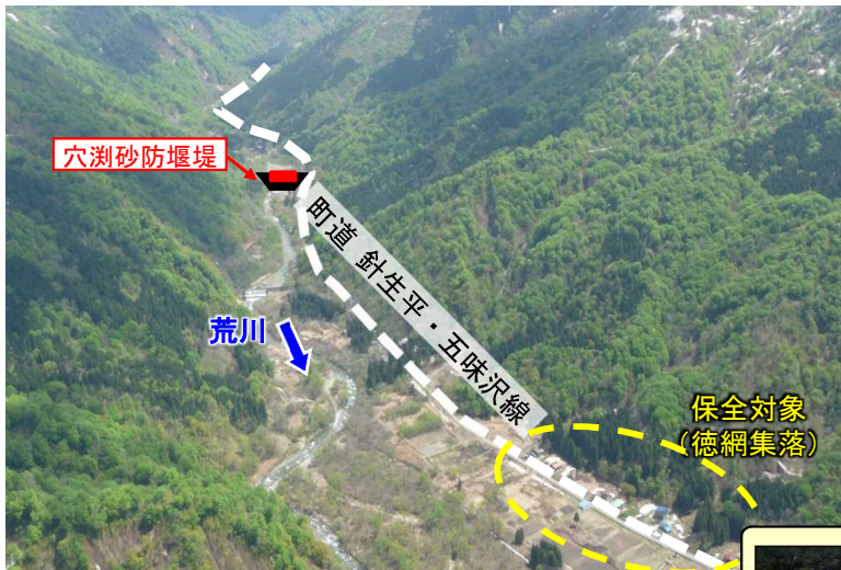
穴沢砂防堰堤 (下流上空より望む)
