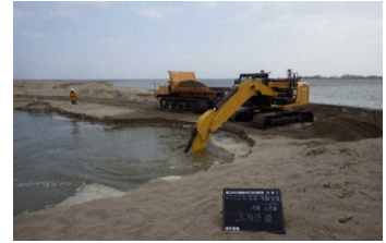
堆積土砂の撤去 (対策イメージ)
