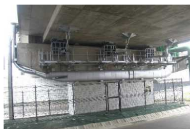
（対策イメージ：落橋防止装置）
