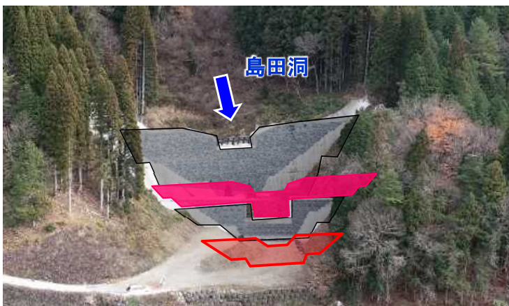
島田洞砂防堰堤（整備中）
