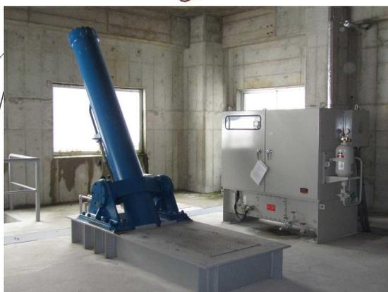
コンジットゲート開閉装置
