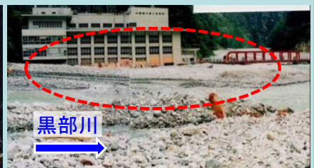
土砂流出により発電施設が埋没
