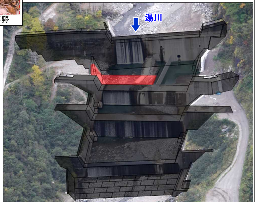
水谷第3号砂防堰堤
