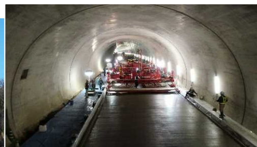
▲舗装工事(トンネル内)の施工状況
