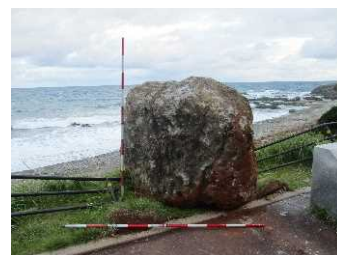
被災状況（落石）
