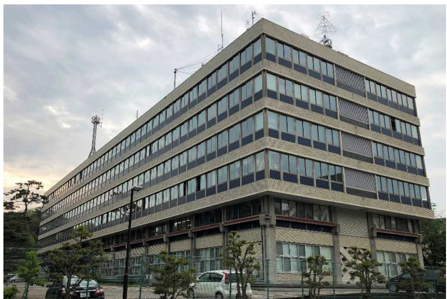
【金沢広坂合同庁舎外観写真】
