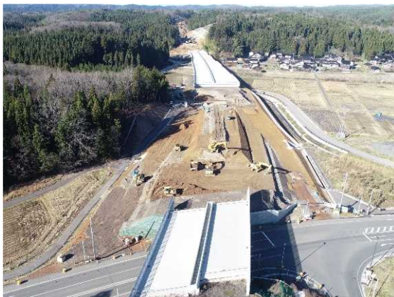
▲改良工事の施工状況
