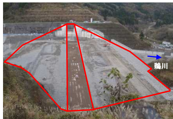
施工状況写真【右岸よりダムサイトを望む】
