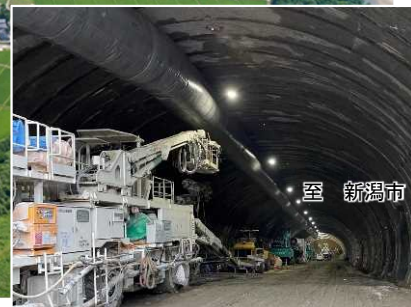
▲ 4号トンネルの掘削状況
