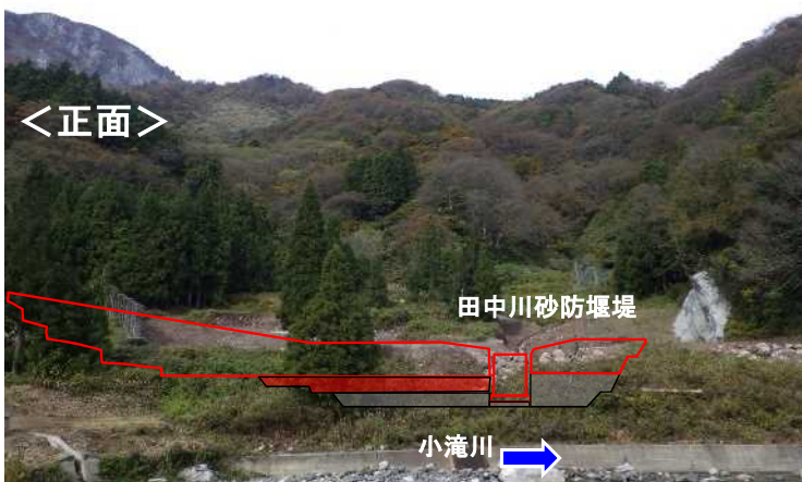
田中川砂防堰堤(整備中)
