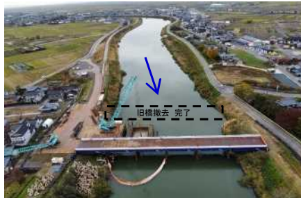
旧橋梁の撤去完了 新設橋梁工の推進
