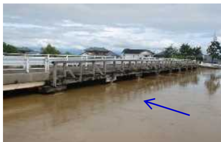
旧橋梁が流下を阻害 （越流による破堤の危険）
