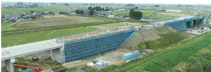
▲ 橋台背面の軽量盛土施工状況
