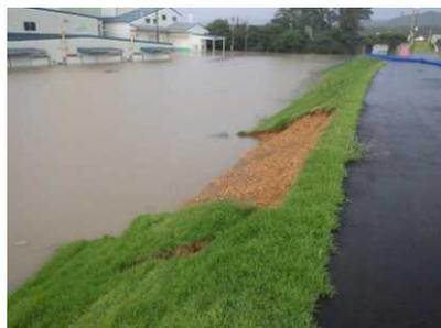
損傷した堤防の復旧（撮影：令和4年8月）
