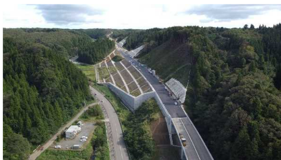
▲改良工事の施工状況
