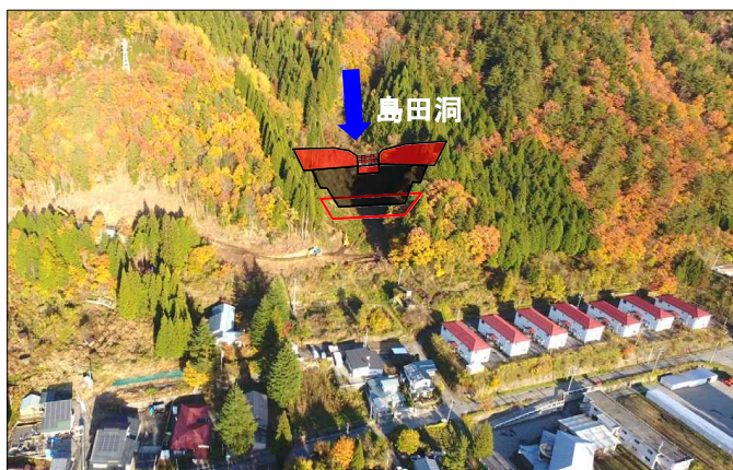
島田洞砂防堰堤(整備中)
