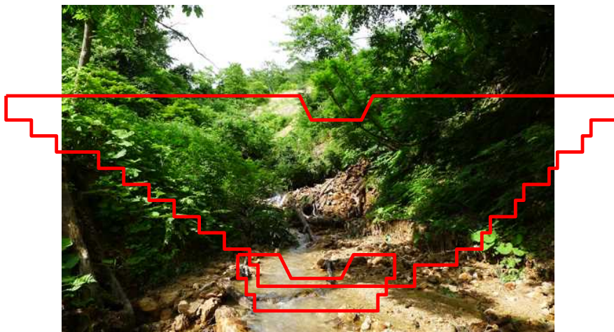
杉立沢砂防堰堤（整備中）
