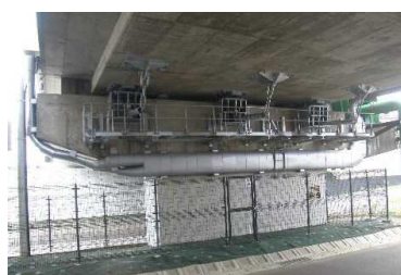
（対策イメージ：落橋防止装置）
