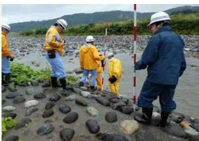
点検による状態把握(堤防点検)
