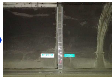
（対策イメージ： 断面修復・漏水対策）
