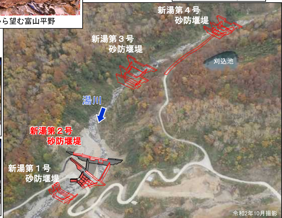
事業箇所の全景
