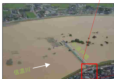
◀【写真左】出水時の こすど 小須戸橋
