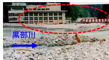
H7年7月 土砂流出により発電施設が埋没
