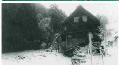
S42年8月 羽越災害時に馬取川の土砂・洪水氾濫で倒壊寸前の人家
