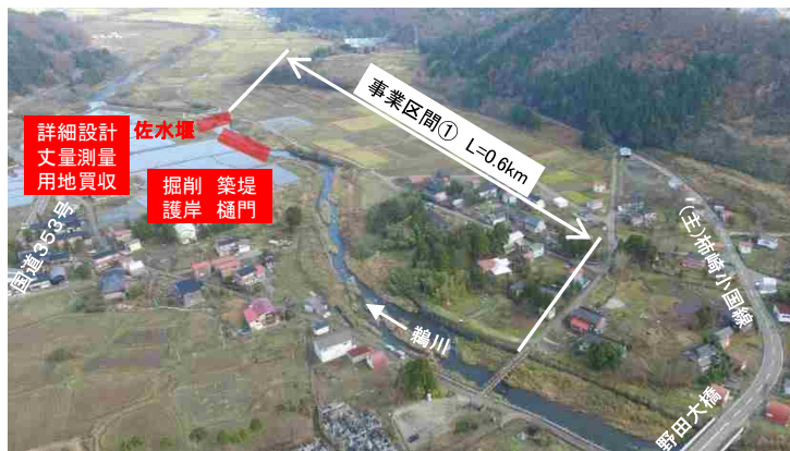
未改修区間（事業区間①）の状況
