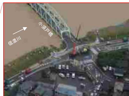
▲【写真上】 こすど 小須戸橋右岸の水防活動
