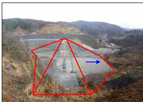
ダム本体施工状況（令和元年12月撮影）
