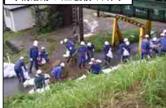
水防活動の(土嚢積み)様子
